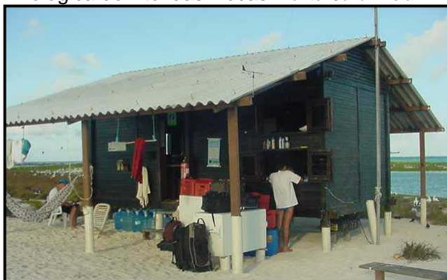
Considerando as varandas, a área construída é de aproximadamente 54m<sup>2</sup>, medindo 6m de frente por 9m de largura. A casa propriamente dita, mede 6m x 3m (18m<sup>2</sup>), montada sobre pilotis de concreto revestido com cano de PVC de aproximadamente 1m de altura, o que impede o acesso de animais como caranguejo e rato ao interior da sede, além de protegê-la contra fortes ressacas (a água flui por debaixo da casa).
