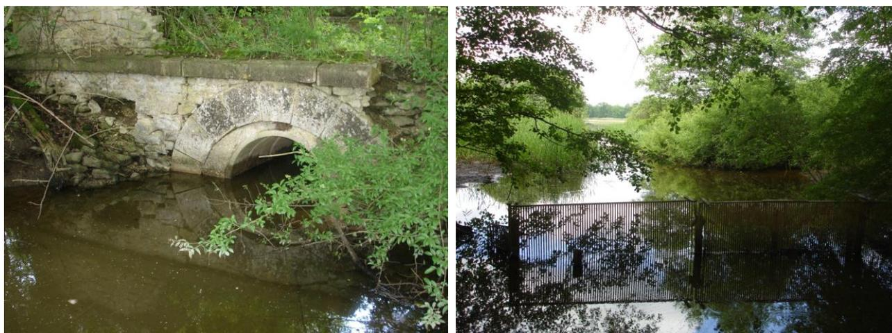
*Arrivée des eaux du Ru de la Dame surmonté par un pont très ancien, alimentation principale de l'Étang de Ramerupt, juste au sud de celui-ci ; une grille métallique, située juste en amont de l'étang, permet de filtrer les branches et autres éléments flottant pouvant arriver dans le Ru de la Dame (clichés : Yohann BROUILLARD, CENCA, juin 2013)*
